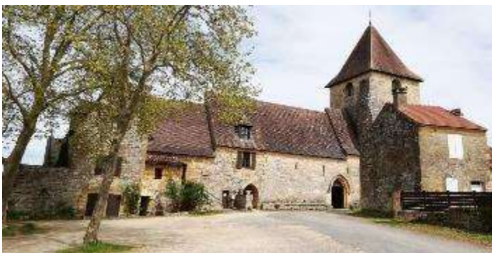
Le bâtiment principal
