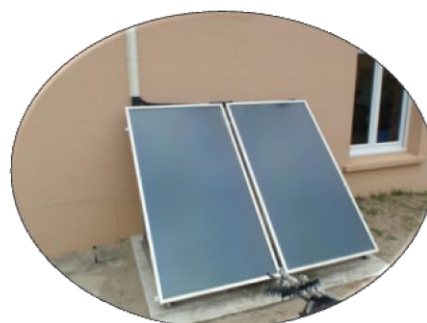
LES PANNEAUX SOLAIRES
